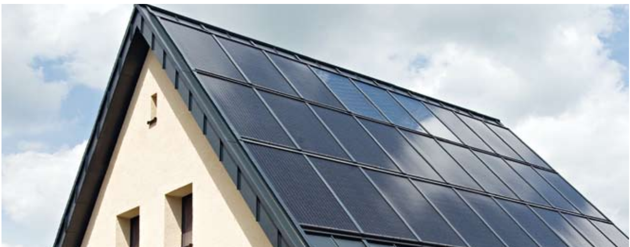
Wohnhaus in Münster Solaranlage 6,3 m 2 zur Trinkwassererwärmung in Kombination mit 6,5 kWp Photovoltaik
