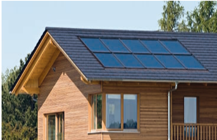
Wohnhaus in Windach Solaranlage 21,3 m 2 zur Trinkwassererwärmung und Heizungsunterstützung
