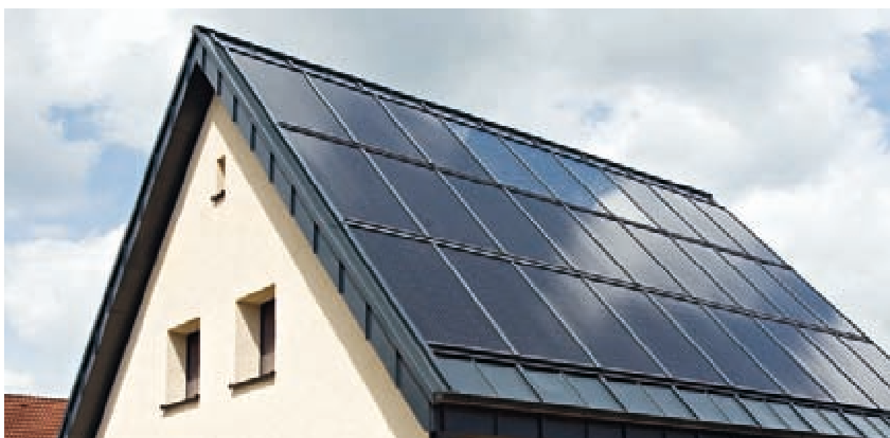
Wohnhaus in Münster Solaranlage 6,3 m 2 zur Trinkwassererwärmung in Kombination mit 6,5 kWp Photovoltaik
