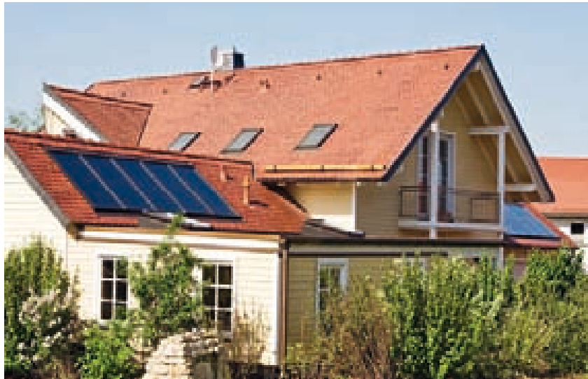
Wohnhaus in Dingelstedt Solaranlage 21,3 m 2 (Ausschnitt) zur Trinkwassererwärmung, Heizungsunterstützung und Schwimmbaderwärmung
