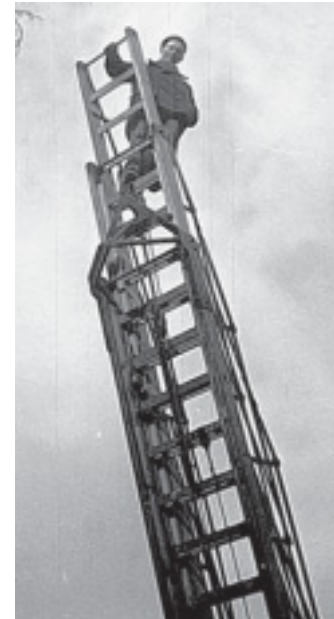
Schwindelfrei: Rudolf Lang arbeitet von einer Drehleiter aus.
